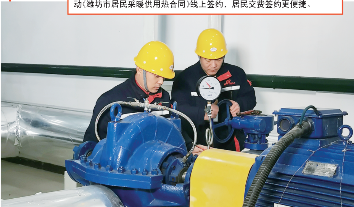
山东高创热力有限公司工作人员在检查维修供暖设备。
