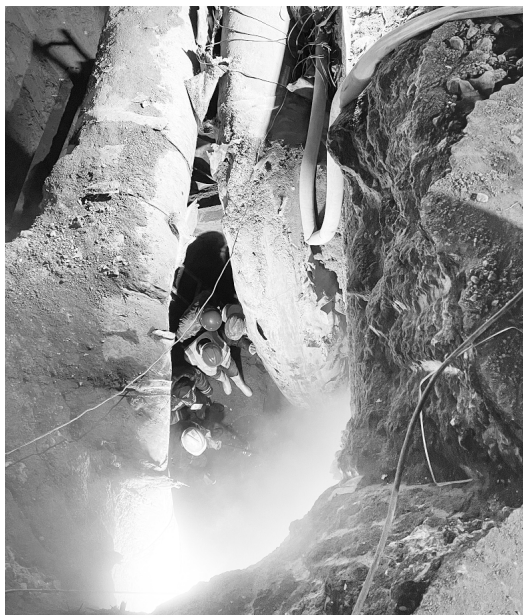
12月1日凌晨,施工人员冒着严寒抢修作业。
