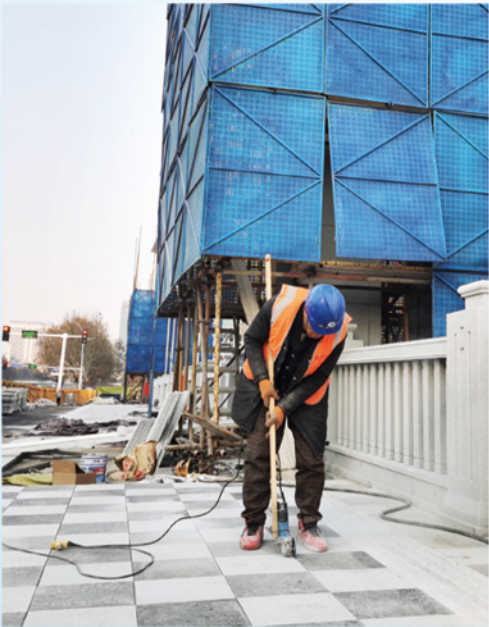
▲施工人员对东风桥人行道进行施工。
