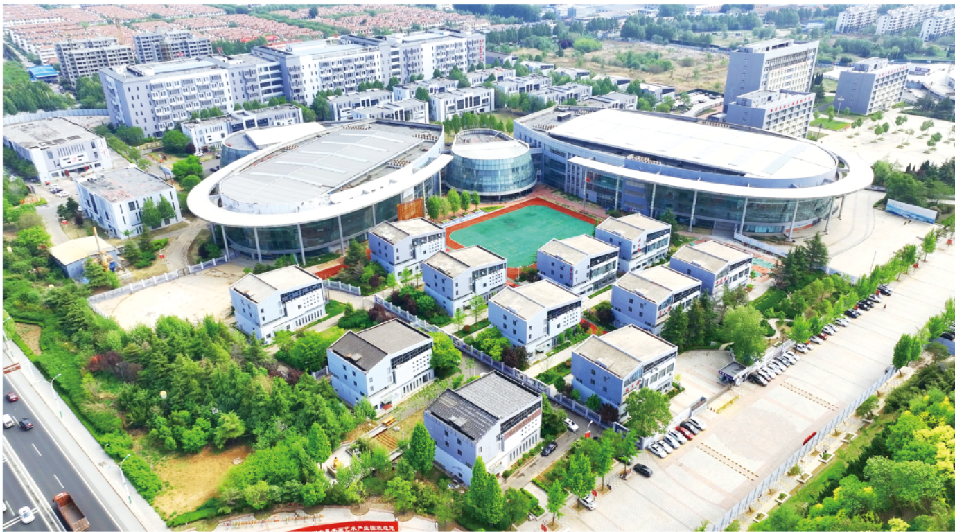
青州圣维科技高中校园。
