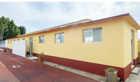
改造完成的厕所焕然一新。
