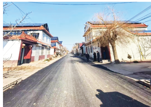
吕家庄一村村内主干道竣工启用。
