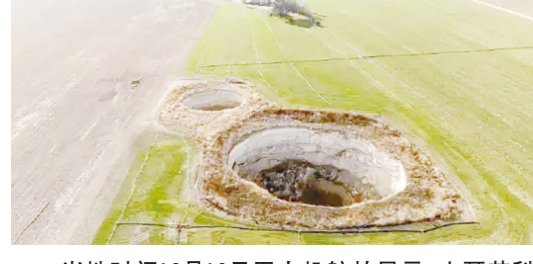
当地时间12月18日无人机航拍显示，土耳其科尼亚省一处农田出现塌陷坑。
