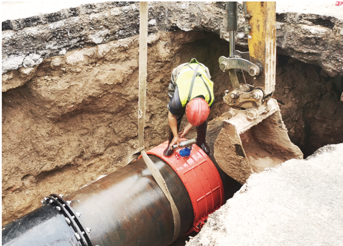
抢修人员对完成抢修作业的供水管道进行调试。
