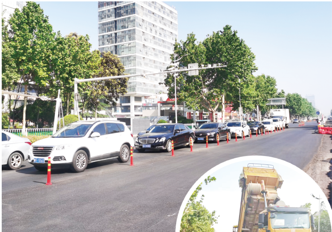
城区向阳路卧龙西街至玄武西街路段在进行破损路面整治。
