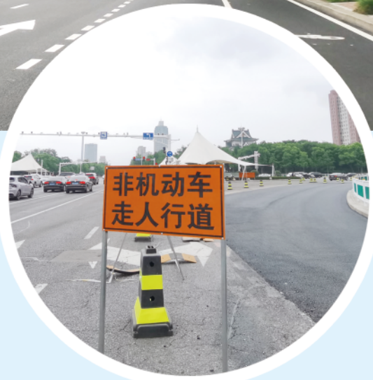
城区东风东街与北海路交叉口,右转辅道位置正在施工。
