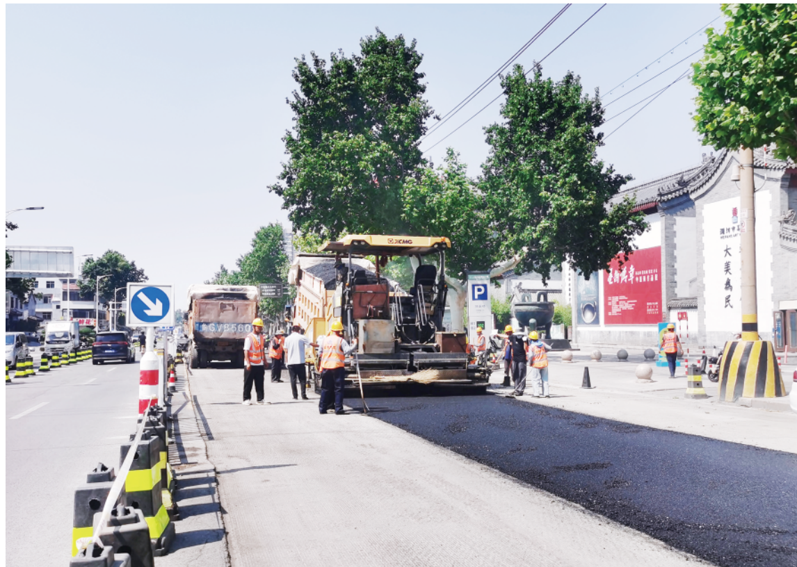
城区东风西街与向阳路交叉口北侧路面正在改造提升。
